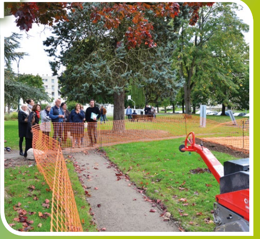
La place Davidsen en travaux
